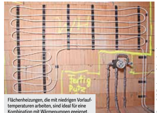
Wärmepumpen mit Tiefenbohrungen sind hocheffizient, aber technisch aufwendig.
